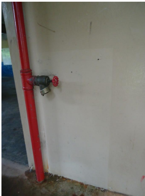
Figura 64 - Local onde havia abrigo instalado.
