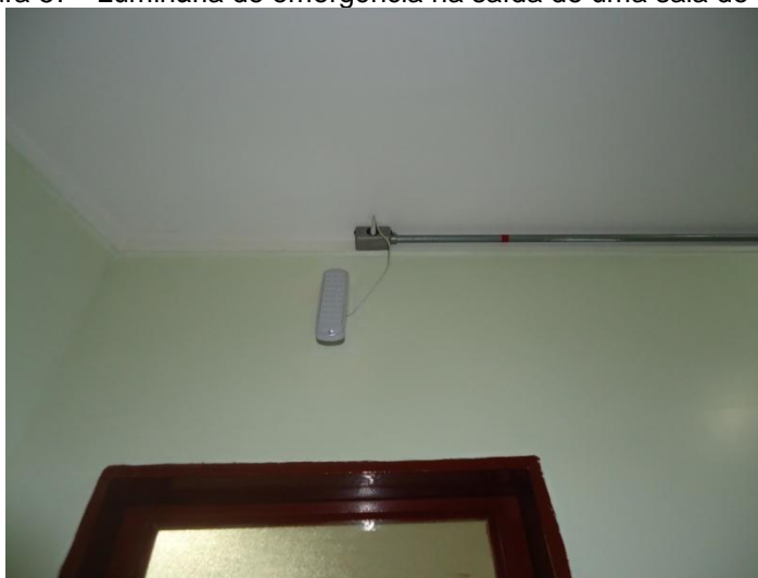
Figura 57 - Luminária de emergência na saída de uma sala de aula.
