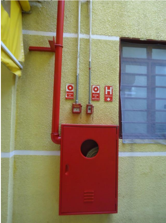
Figura 61 - Abrigo com hidrante localizado no pátio
