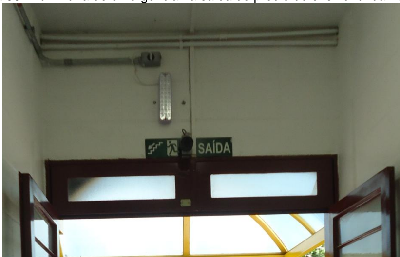
Figura 56 - Luminária de emergência na saída do prédio do ensino fundamental II.
