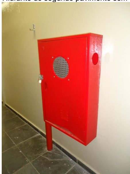
Figura 43 - Hidrante do segundo pavimento sem sinalização.
