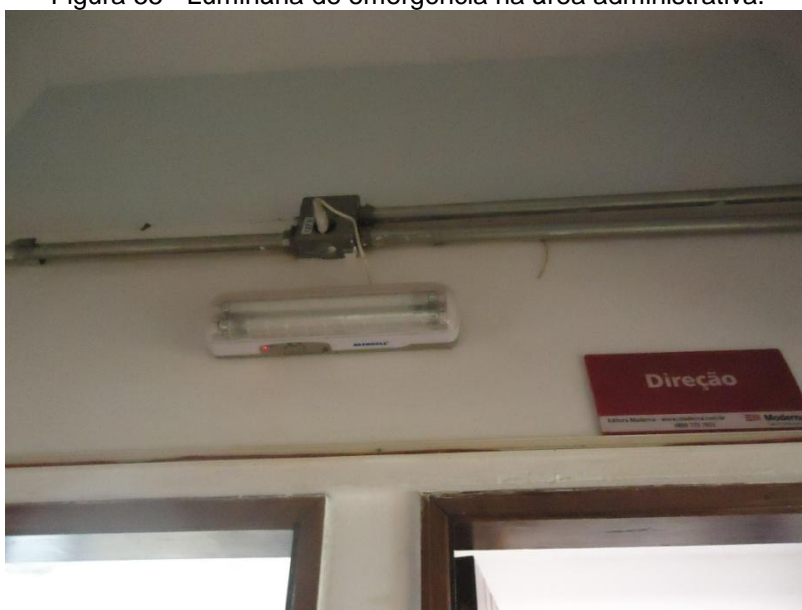
Figura 55 - Luminária de emergência na área administrativa.
