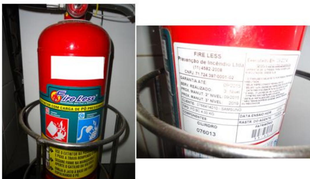
Figura 51 - Extintor da cozinha e informações de manutenção.
