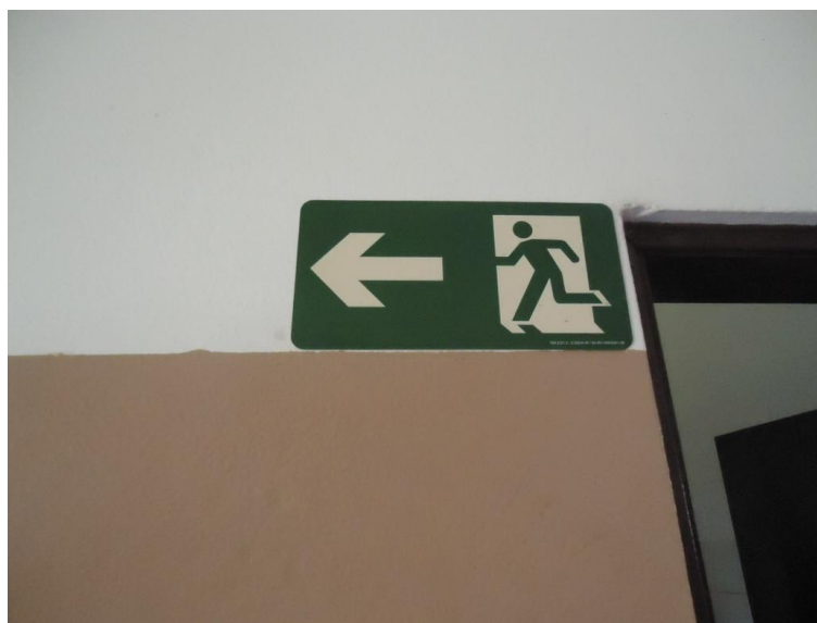
Figura 42 - Sinalização de orientação de saída de emergência no corredor.
