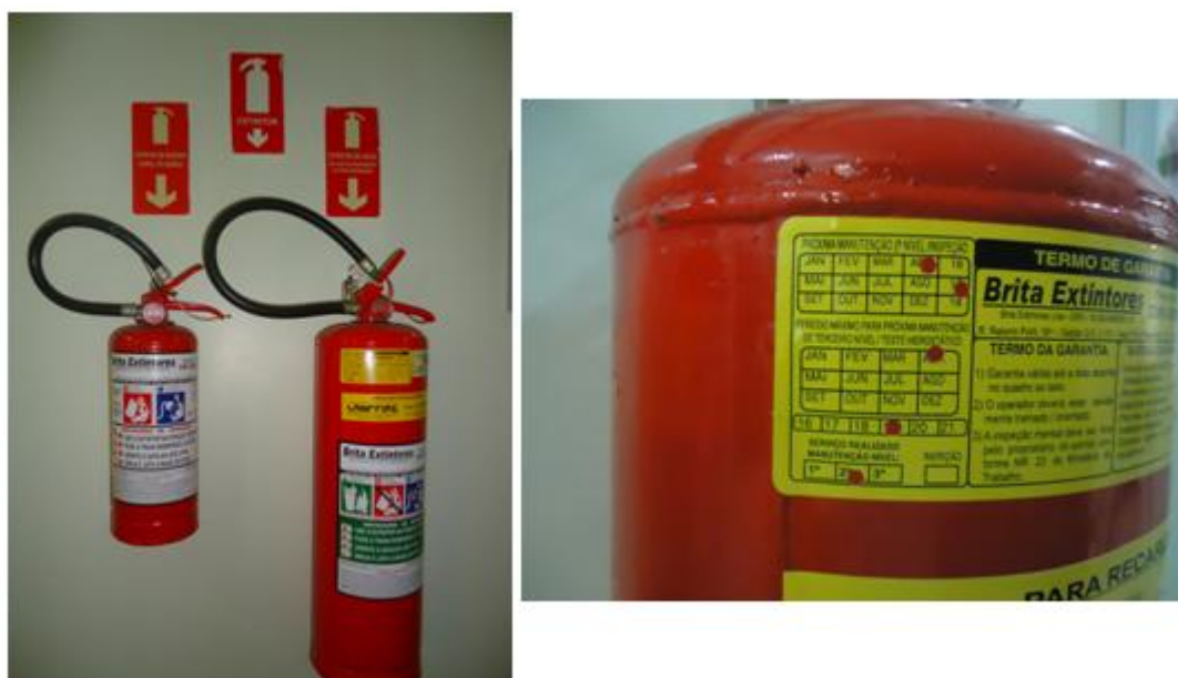
Figura 52 - Extintores BC, A e informações de manutenção.
