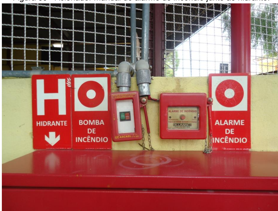
Figura 59 - Acionador manual do alarme de incêndio junto ao hidrante.
